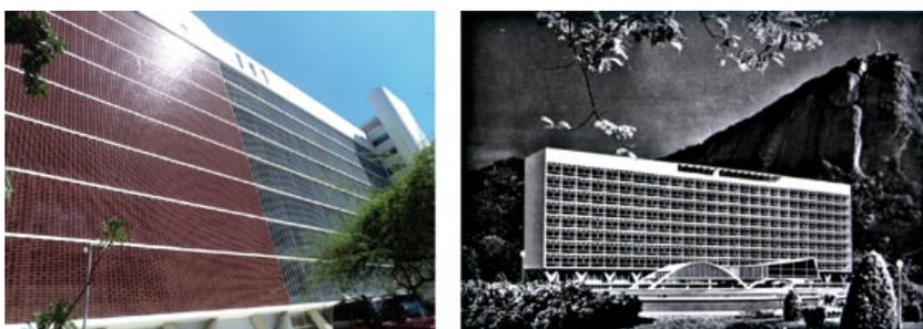
**Figuras 21 e 22.** Soluções de fachada norte protegida por cobogó e brise soleil projetadas por Oscar Niemeyer para o Hospital da Lagoa, Rio de Janeiro, 1958
